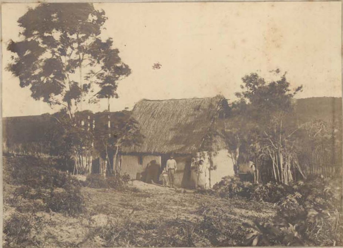
Alojamento construido no lote n. 5 pelo concessionario ADAM KRAMIN, chegado ao Nucleo em 19 de Junho de 1906 e procedente da RUSSIA.
