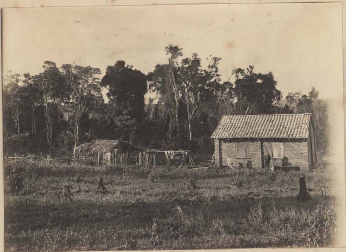
Casa construida no lote n. 20 pelo concessionario JOHAN MES- CHGRAHW, chegado ao Nucleo em 14 de Julho de 1906, procedente da RUSSIA.
