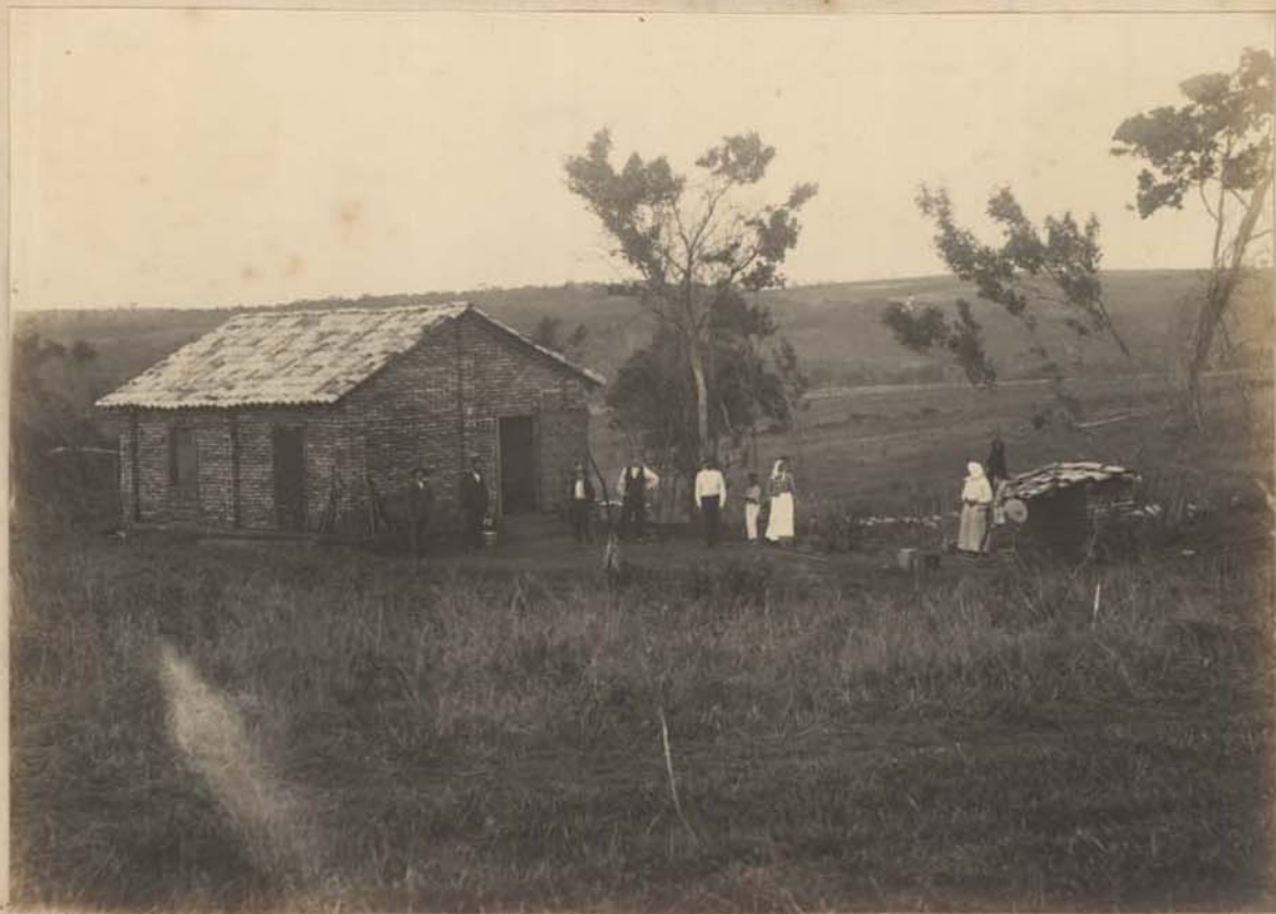
Casa de moradia construida no lote n. 29 pelo seu concessiona- rio JOHAN ADAMSON, chegado ao Nucleo em 29 de Junho de 1906, procedente da RUSSIA.
