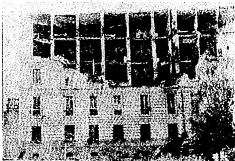
NAPLES — Aspecto de uma casa na Ponte Casanova, da qual desabaram os pavimentos superiores.
